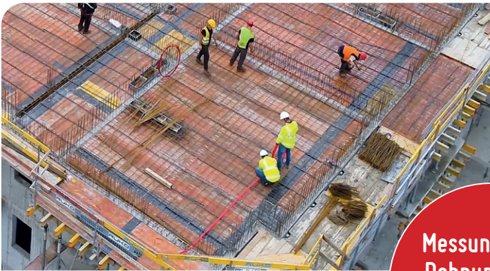
Installation des 3DSensors innerhalb der Stahlbetonplatte
