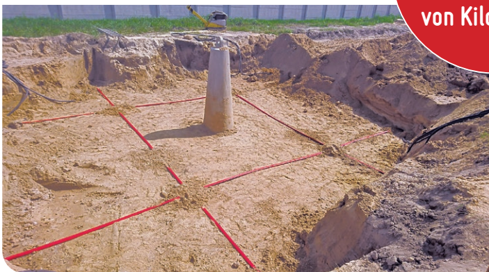
Messung einer vertikalen Verschiebung – F&E-Bereich
