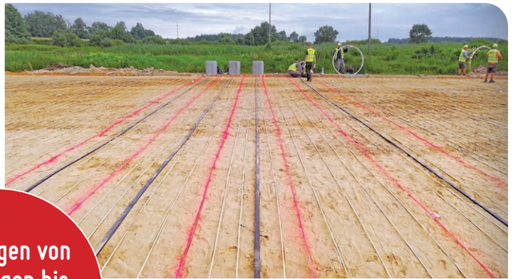
Anwendung des 3DSensors in einer Straßenböschung
