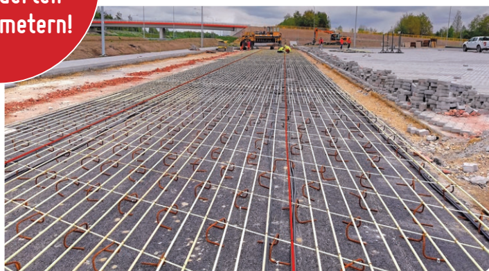
Anwendung von EpsilonRebar in einer intelligenten Betonautobahn
