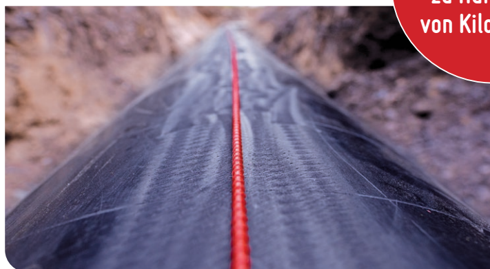
Anwendung von EpsilonRebar an einer Gasrohrleitung aus Stahl
