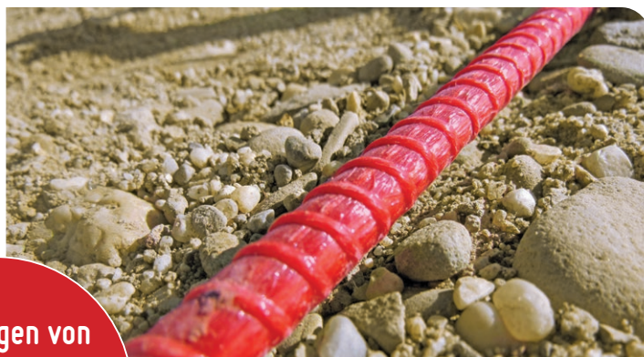
Straßenböschung mit EpsilonRebar
