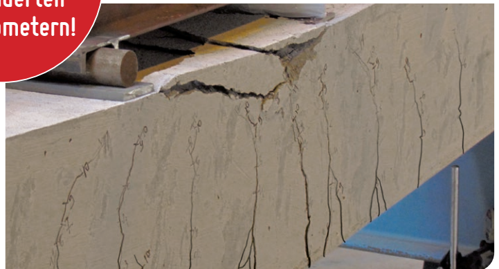
Rissmessungen mit EpsilonSensor während Biegeversuchen
